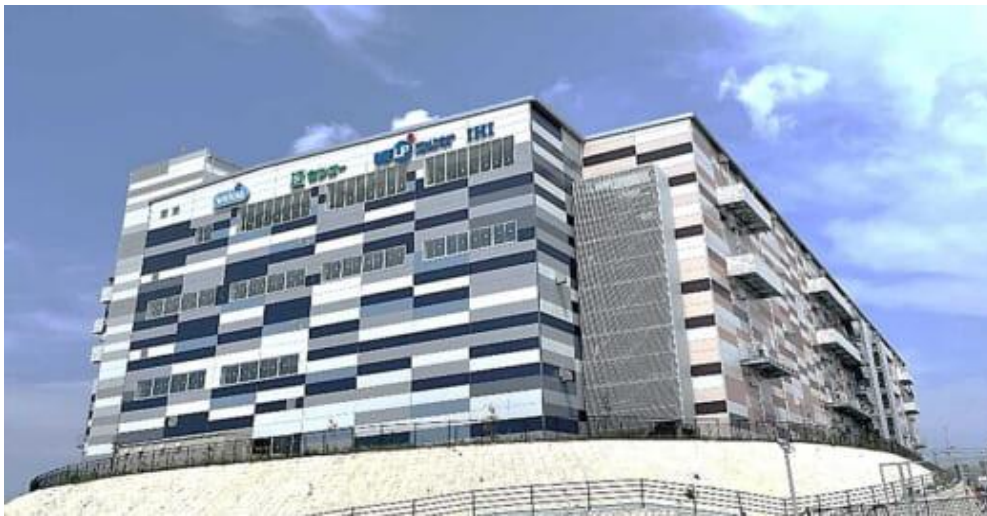
ウエルシア西関東 RDC
