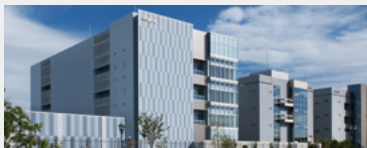
岡山データセンター
