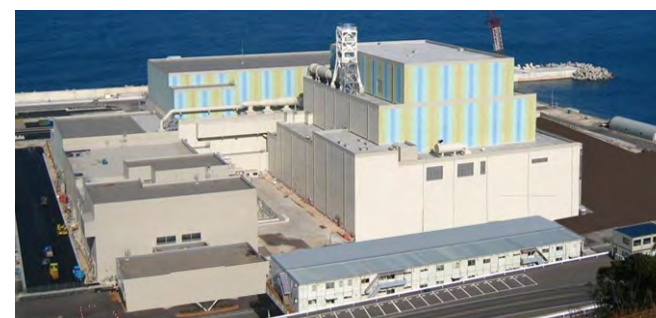
中国電力株式会社 島根原子力発電所3号機(建設中)
