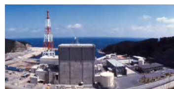
1974年 国産第1号商用炉の島根原子力発電所
