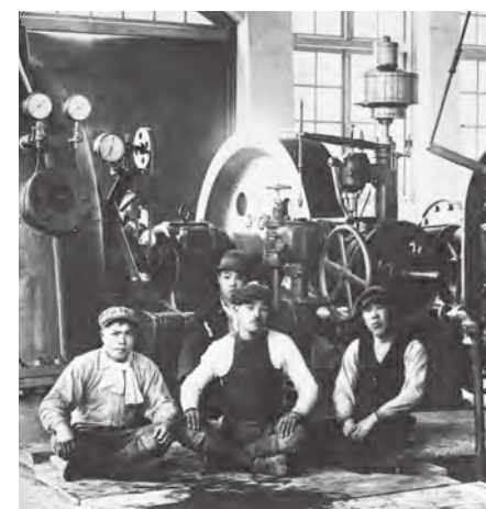
日立鉱山発電所 (1916年撮影)
