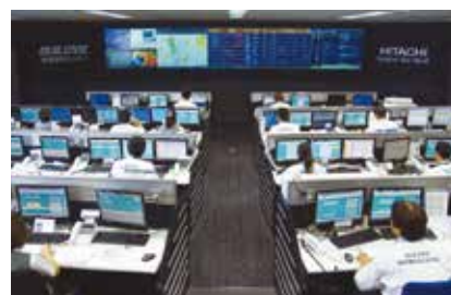
ビル設備の遠隔監視を行う管制センター
