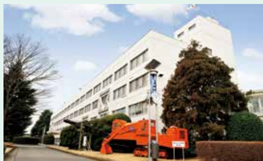
土浦工場東館と機械遺産認定の油圧ショベルUH03
