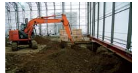
土壌の掘削作業
