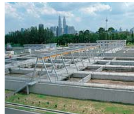
プヌス下水処理場 (マレーシア)
