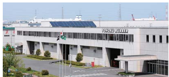
太陽光発電の電力(最大出力10kW)を工場で使用
