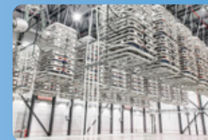
例：再エネ大量導入に向けたHVDC変換所
