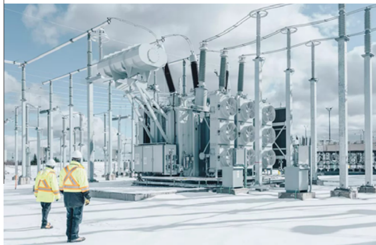
変圧器のリサイクルに向けた取り組み
