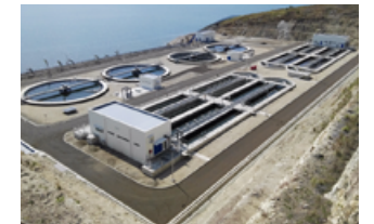
下水処理場の全景
