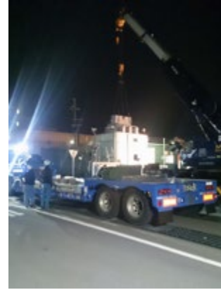
PCB廃棄物(大型変圧器)の搬出作業
