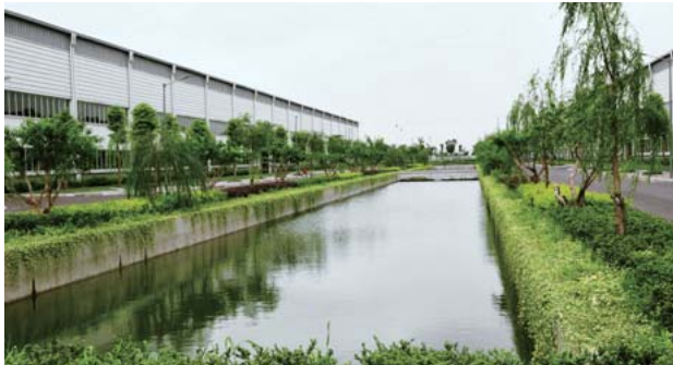
処理済みの再生水を貯留する工場内の池
