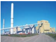
キーブヒルズ発電所3号機(カナダ)
