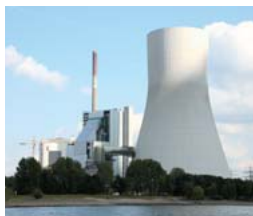
超々臨界圧石炭火力発電プラント※
