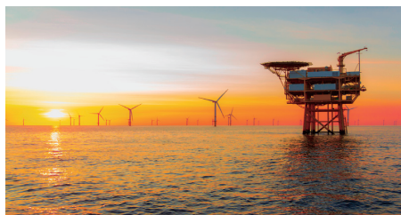
洋上風力向け変電設備群
