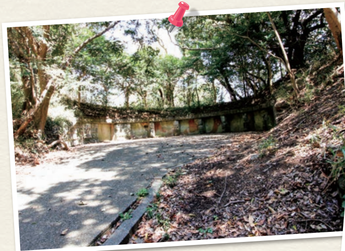
▲ 三軒家砲台跡 観音崎に多く残る砲台跡のひとつ。日清戦争が終結した 1896年に竣工しました
