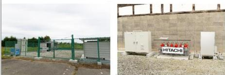
（写真左）浪江町の大震災防災コミュニティセンターに設置された水素充填・燃料電池設備
