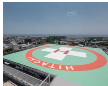
▲ 屋上ヘリポート
