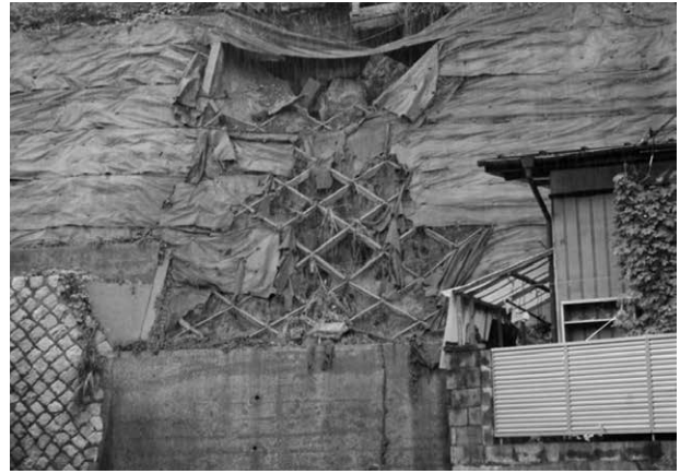
水戸側 敷地境界沿い法面
