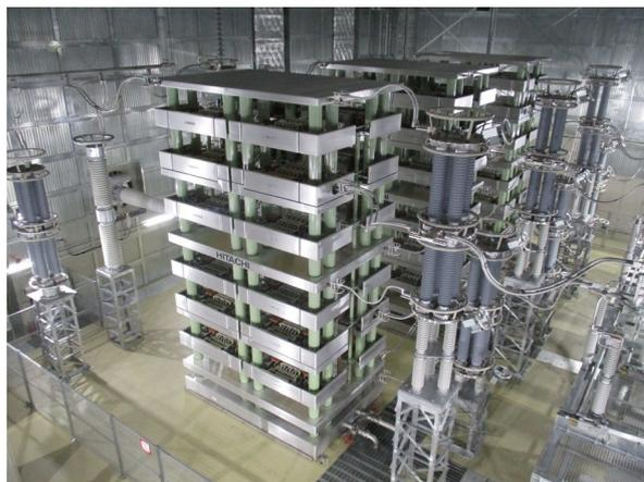
他励式 HVDC のバルブホール(交直変換装置)
