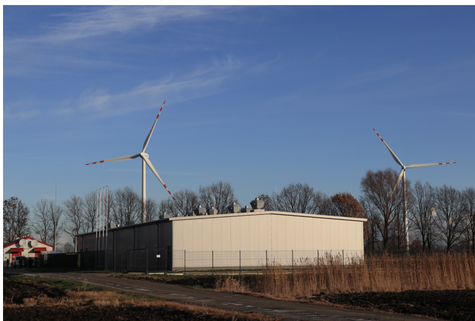
図1 ビストラ風力発電所に併設したハイブリッド BESS 建屋
