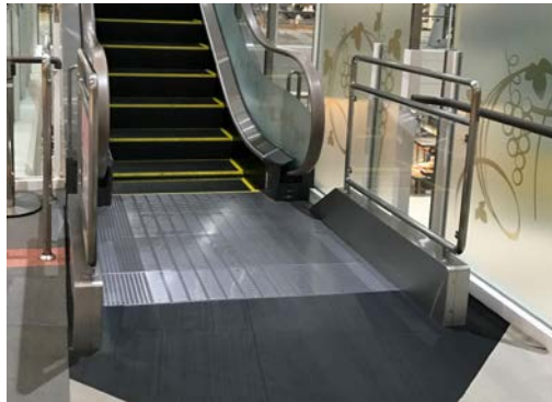
耐震強化工事後のイオンモール甲府昭和のエスカレーター
