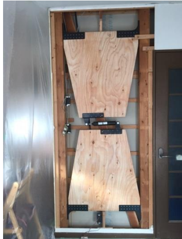
戸建住宅・制震リフォーム用「柱取付型オイルダンパー制震装置」
