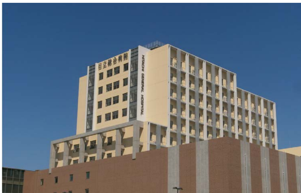
日立総合病院本館棟 外観
