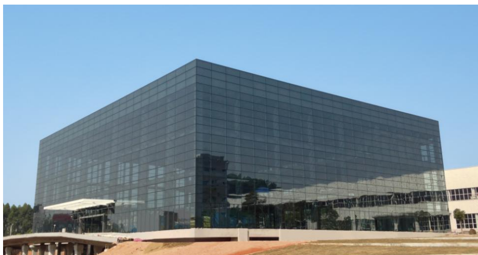
日立昇降機のショールームの外観
