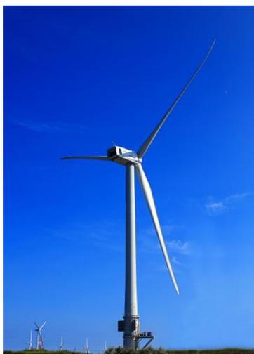
5,000kW 風力発電システム「HTW5.0-126」
