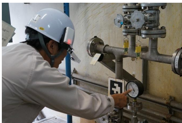
「Doctor Cloud/巡回・点検支援システム」による現場作業イメージ
