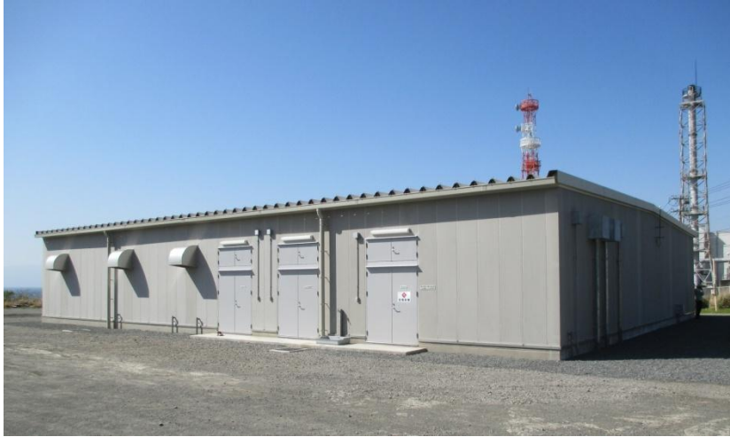
1.5MW ハイブリッド大規模蓄電システム棟外観
