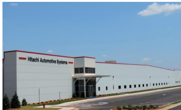
日立オートモティブシステムズアメリカズ, Inc. ジョージア工場 第3製造棟
