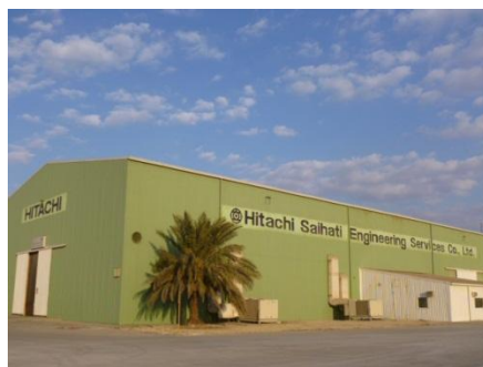
日立サイハチ社のメンテナンスサービス工場外観
