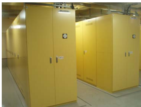
納入したリチウムイオン蓄電池システム
