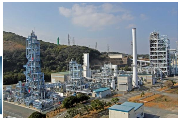
図2: EAGLE パイロットプラント
