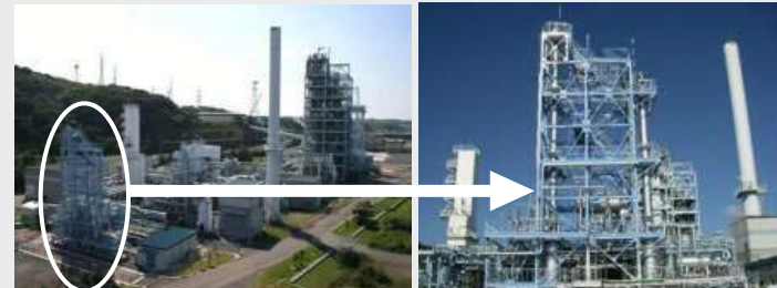
EAGLEパイロットプラント CO 2 分離回収装置
