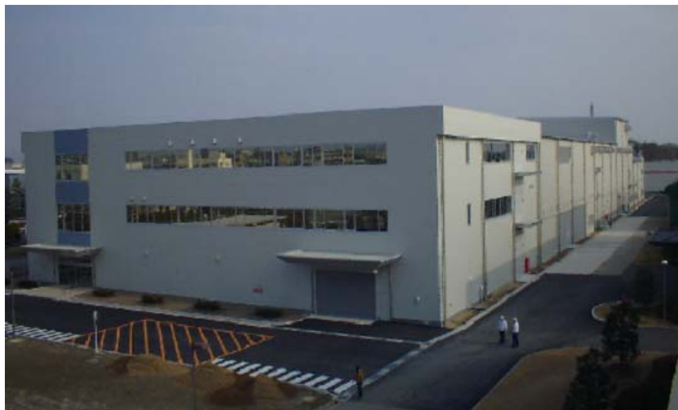
新工場の外観（京都事業所内） 鉄骨2階建、延べ床面積1万5,000m 2
