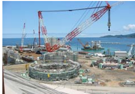
中国電力納め 島根原子力発電所3号機
