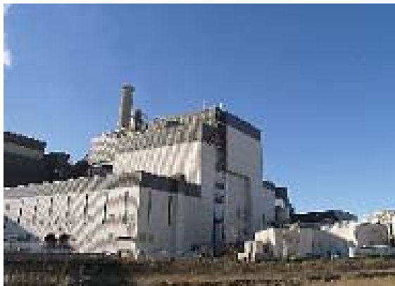
ミッドアメリカン・エナジー納め 米・カウンスルブラフス火力発電所
