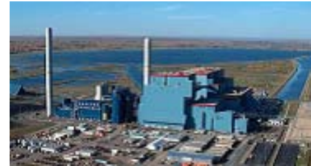
カナダ初 超臨界圧 カナダ・EPCOR社納め 49.5万kW 2005年
