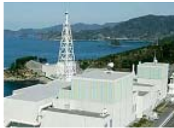
国産第1号 原子力 中国電力納め 46.5万kW 1974年
