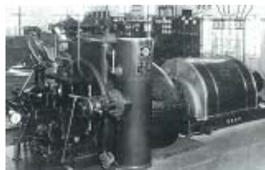
日立初 蒸気タービン 長崎紡績納め 2,800kW 1933年
