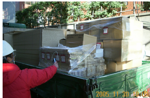
建設現場への搬入時の検品状況 (ハンディ型R/Wで読取)
