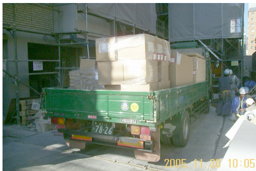
建設現場への搬入状況 (複数品目の積み合せ)
