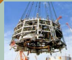
650トンの モジュール工法
