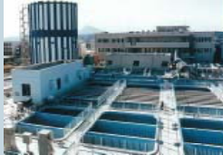
水処理システム
