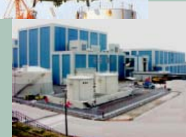
発電設備工事
