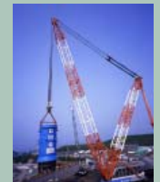
世界最大級 クローラークレーン施工
