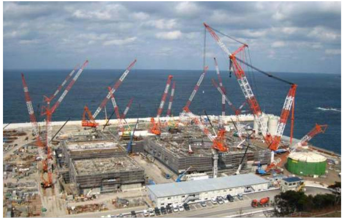
中国電力(株)島根原子力発電所3号機建設
