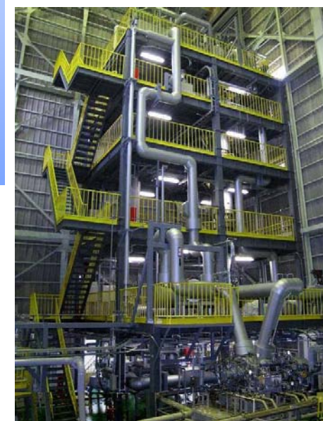
多目的蒸気源試験設備
